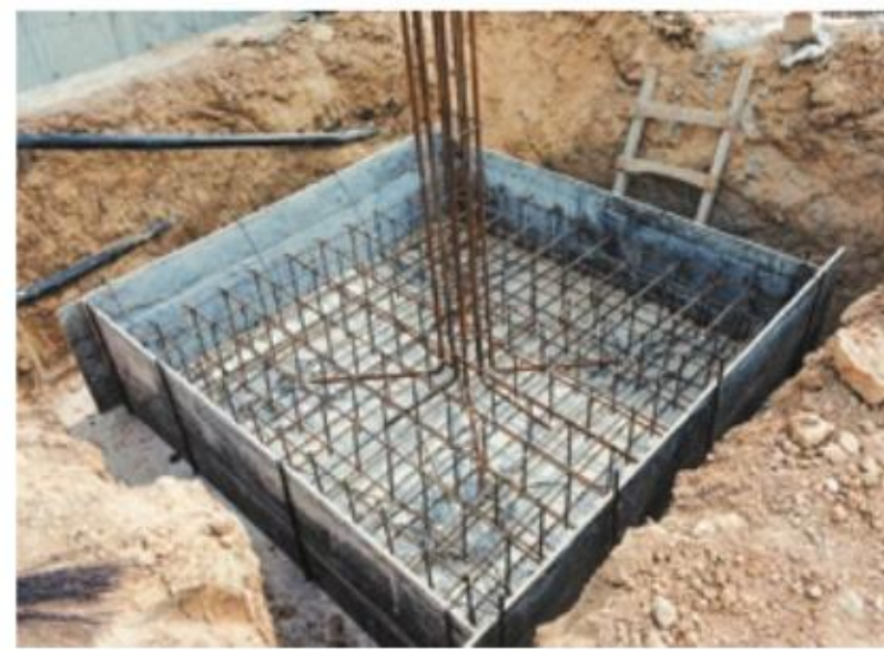
Żelbeton – beton wzmocniony metalowymi prętami
