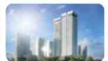
C. in einem Hochhaus
