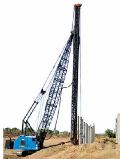
Rys. 5.7. Katar (rodzaj młota) wykorzystuje pracę wykonaną przez spadające masywne obciążenie do wbijania pali w ziemię
