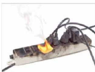
Rys. 15.18. Przeciążenie rozgałęźnika może doprowadzić do pożaru
