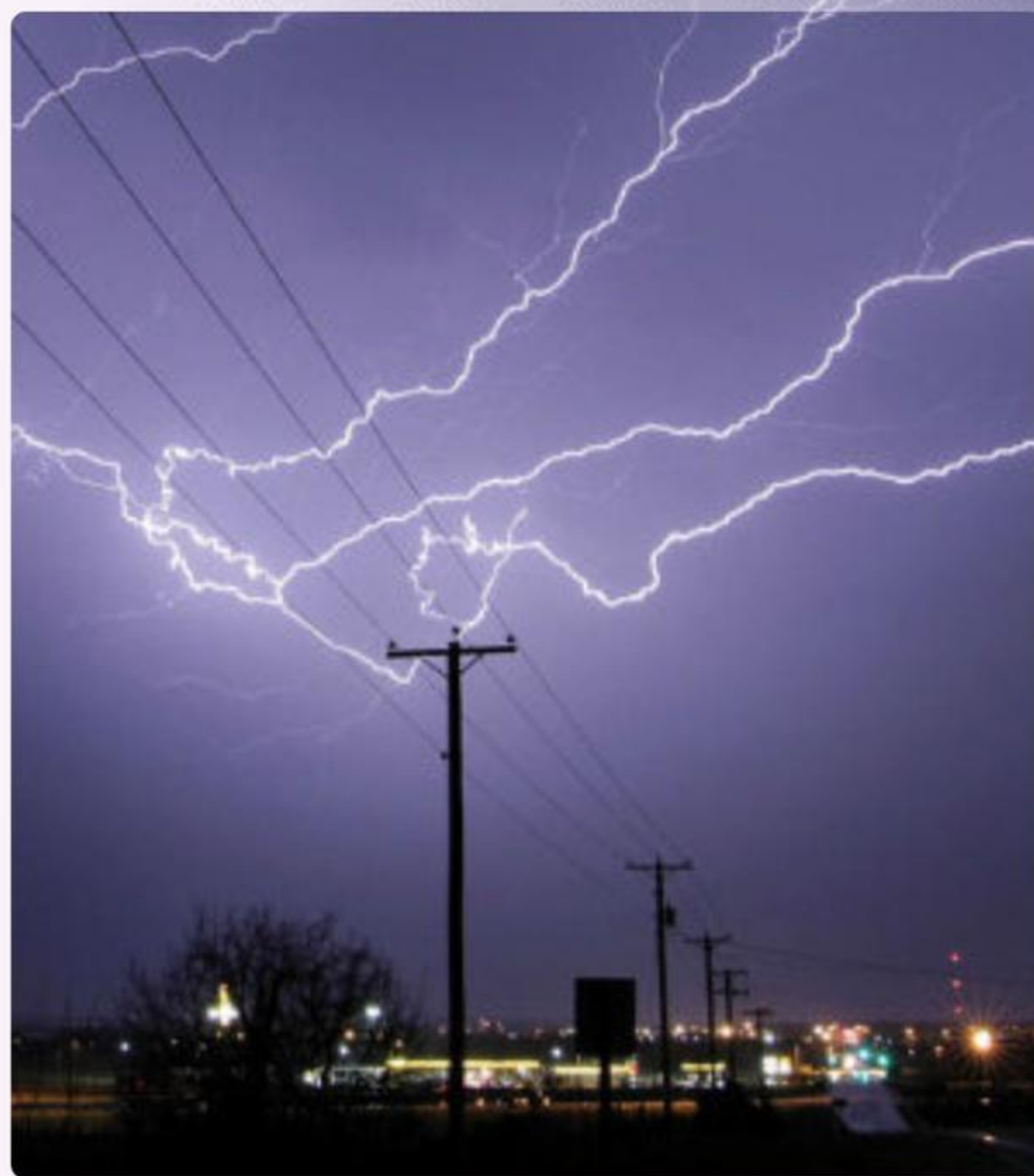
Piorun uderzający w słup linii energetycznej
