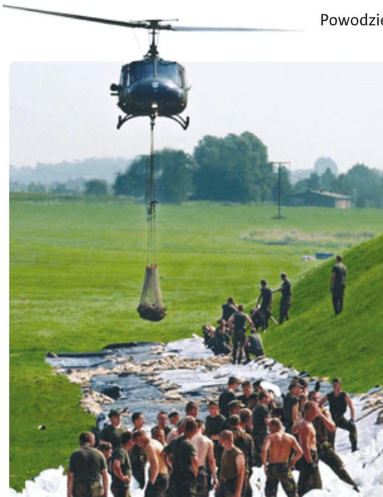
Wzmacnianie tamy workami z piaskiem
