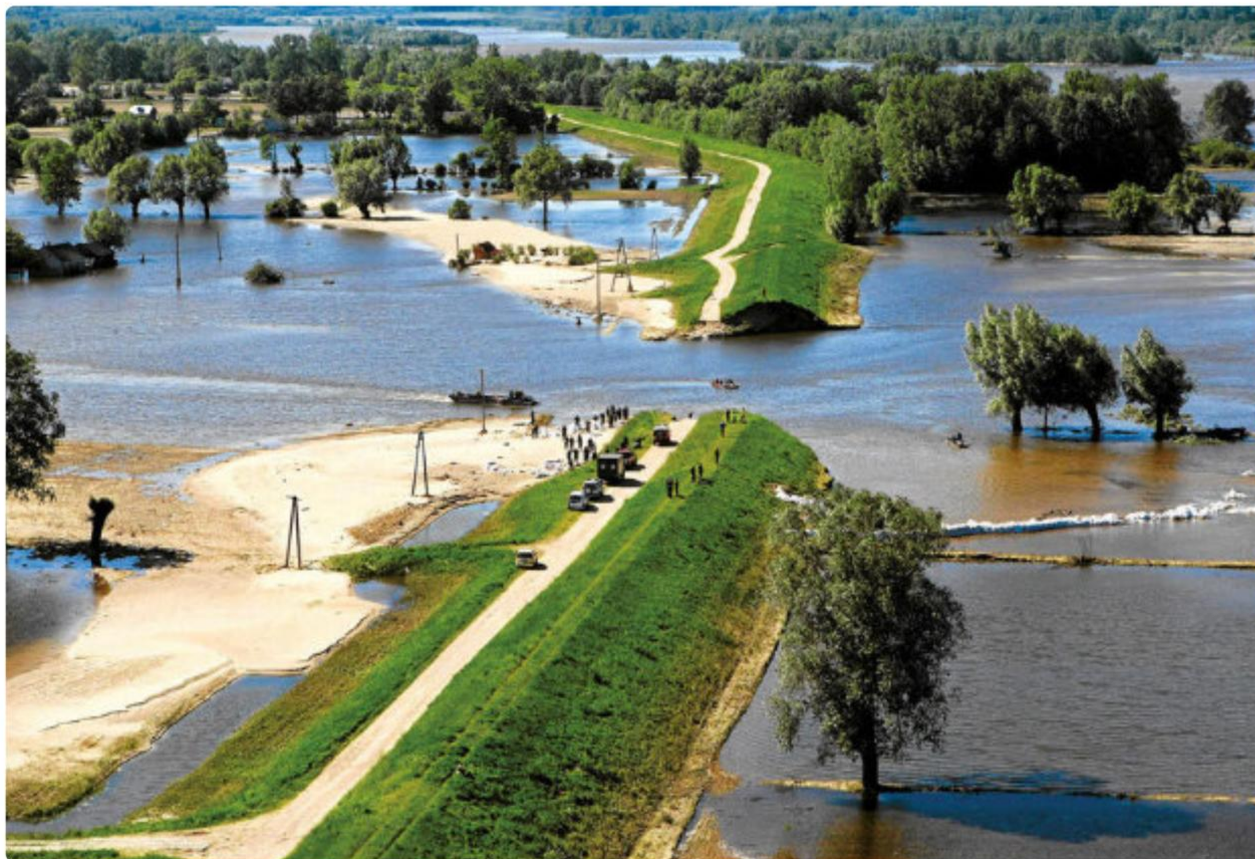
Przerwany wał przeciwpowodziowy na Wiśle, 2010 r.
