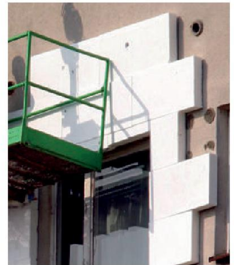
Dodatkowa warstwa izolacji cieplnej na ścianach budynku pozwala oszczędzać energię. Dzięki temu mieszkańcy płacą niższe rachunki za ogrzewanie i pomagają chronić środowisko.
