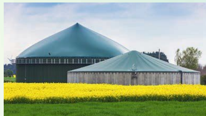
Biogazownia rolnicza umożliwia wytworzenie biogazu z organicznych odpadów rolnych, np. gnojowicy czy odpadów z pól uprawnych.
