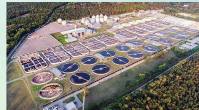
Oczyszczanie biologiczne przeprowadza się w specjalnych zbiornikach i komorach fermentacyjnych.
