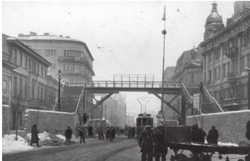
Drewniana kładka nad ul. Chłodną, łącząca małe i duże getto (zdjęcie retuszowane)
