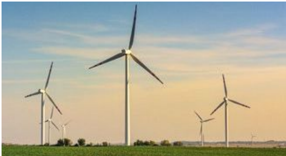
Elektrownia wiatrowa przy Zatoce Puckiej. Najwięcej instalacji tego typu zlokalizowano w województwach kujawsko-pomorskim, wielkopolskim i łódzkim.
