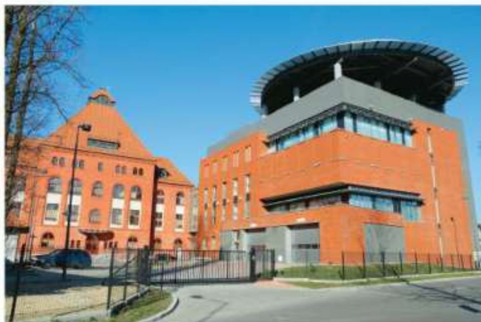
Przykładem infrastruktury krytycznej jest Budynek Centrum Leczenia Oparzeń w Siemianowicach Śląskich.
