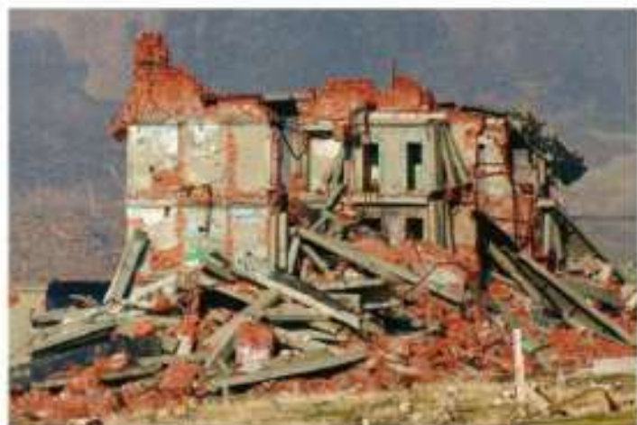
Zawalony budynek mieszkalny
