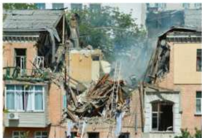
Wybuch butli z gazem w budynku mieszkalnym
