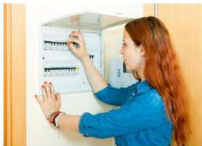
Jeśli jest widoczne iskrzenie instalacji elektrycznej, należy wyłączyć zasilanie prądu.
