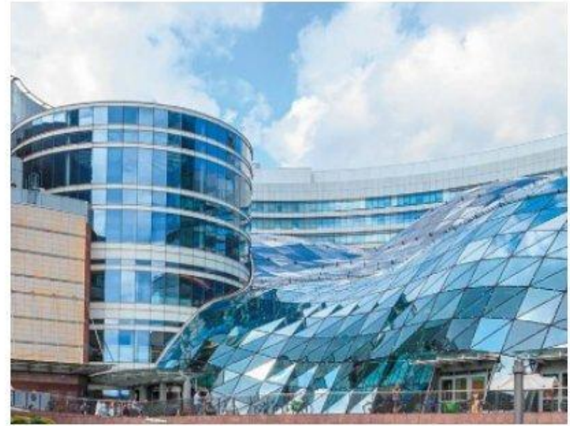
Centrum handlowe Złote Tarasy w Warszawie
