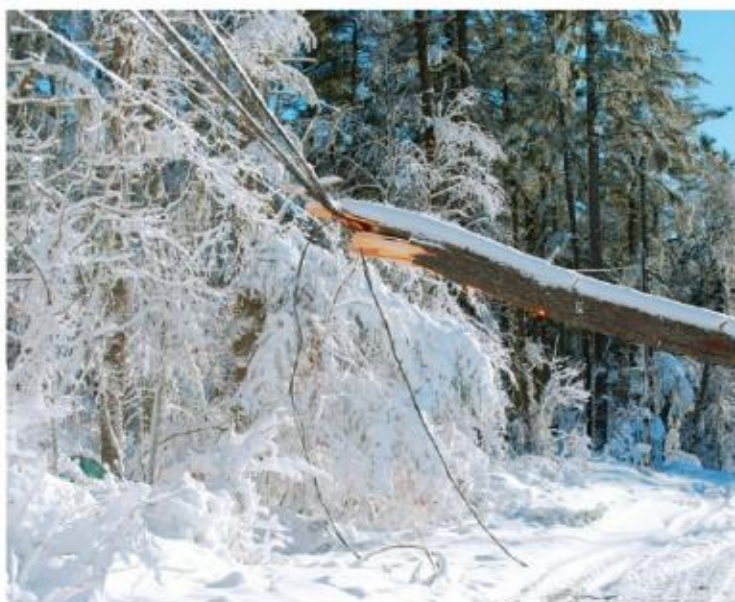
Zdjęcie nr 75. Zerwane linie energetyczne, grudzień 2016 r.
