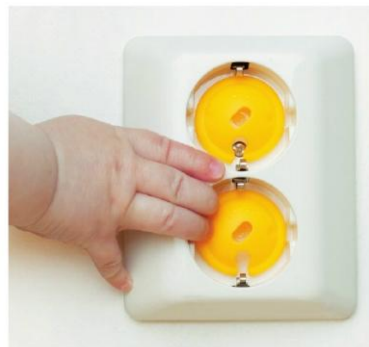
Zdjęcie nr 201. Zatyczki do zabezpieczenia gniazdek
