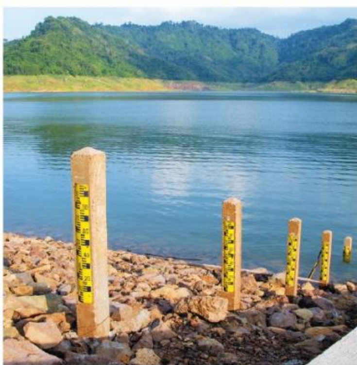
Zdjęcie nr 70. Monitorowanie poziomu wody
