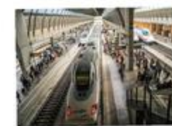
6 Estación de Santa Justa
