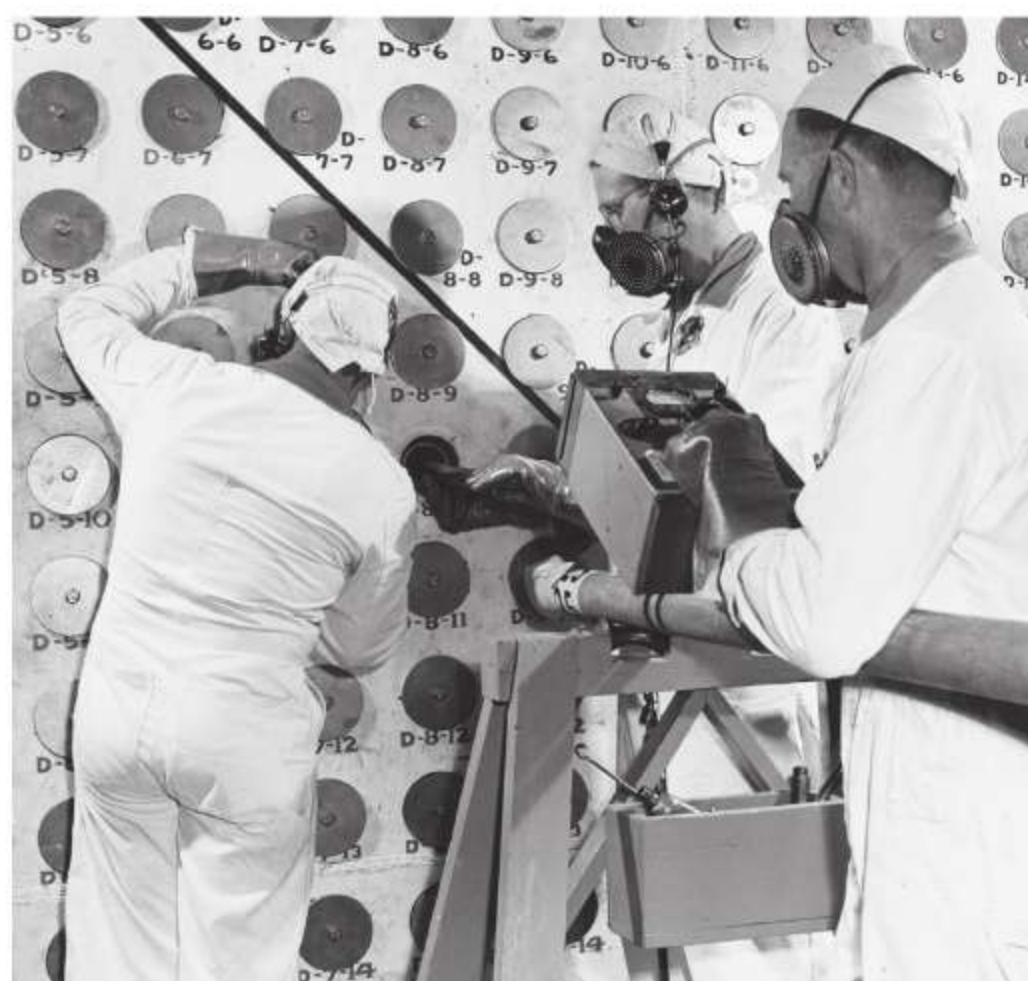
Ryc. 41.3. Wymiana prętów paliwowych wewnątrz wygaszonego reaktora
