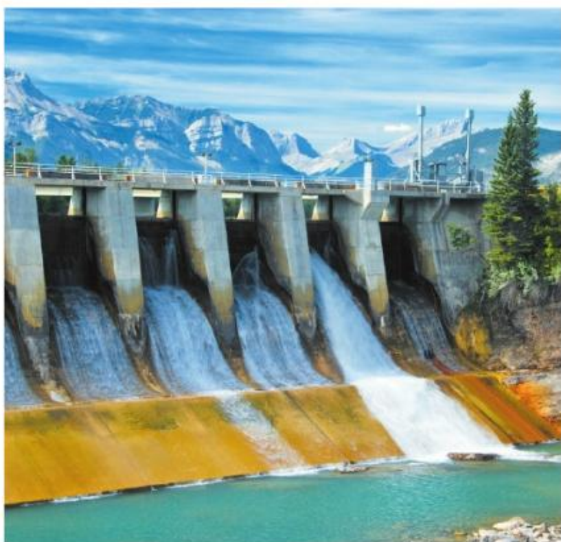
Elektrownie wodne zamieniają energię przepływającej wody na energię elektryczną
