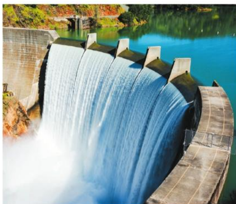
7.16 Woda spiętrzona przez zapórę
