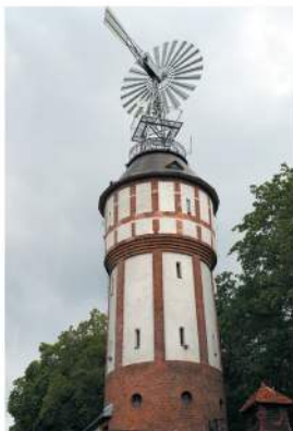
Rys. 23.5 Wiatrak na szczycie wieży napędzał stację pomp i dodatkowo generator prądu
