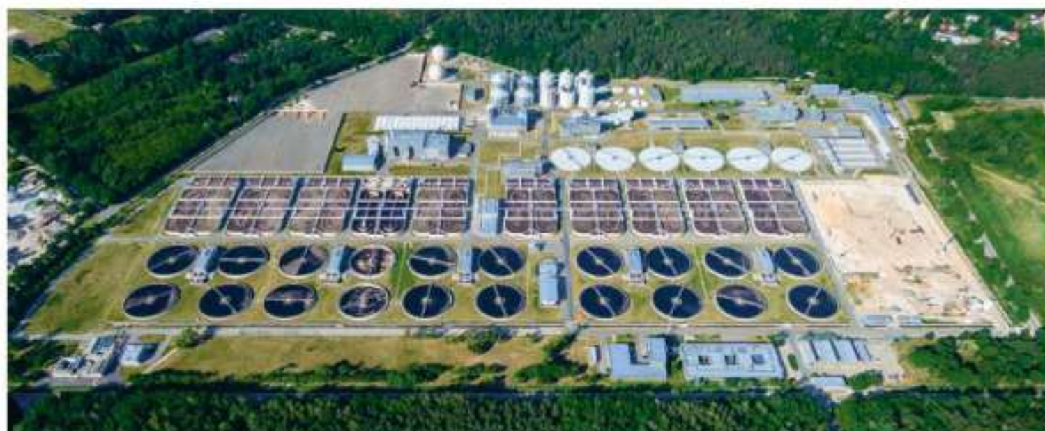
Ryc. VII.5.6. Zakład oczyszczania ścieków komunalnych Czapka (Warszawa).
