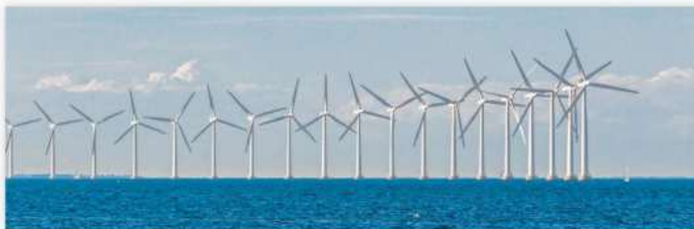
Ryc. V.4.2. Turbiny wiatrowe w Danii, niedaleko Kopenhagi. Turbiny instalowane na morzu mogą być większe i bardziej efektywne niż farmy wiatrowe na lądzie.
