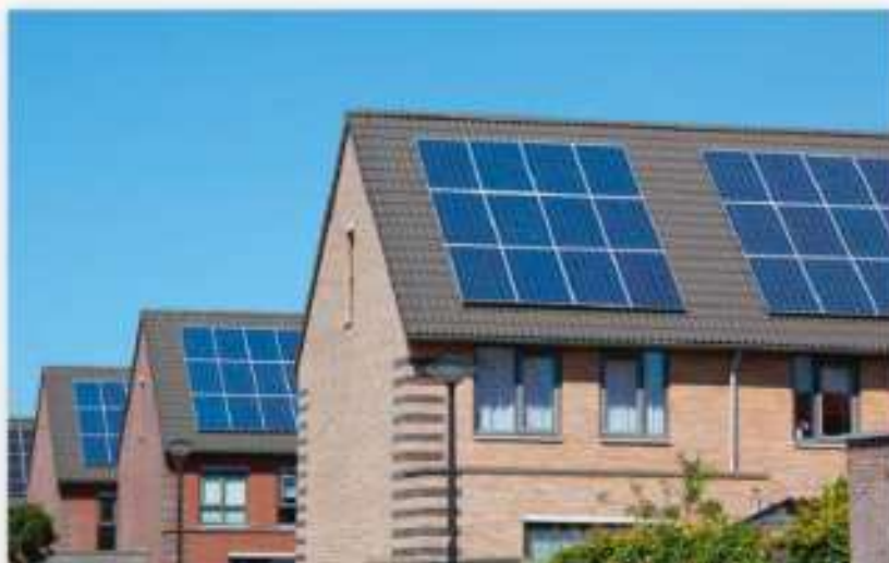
Ryc. VII.8.2. Coraz więcej osób na dachach swoich domów montuje panele słoneczne, które zapewniają ciepło i prąd.
