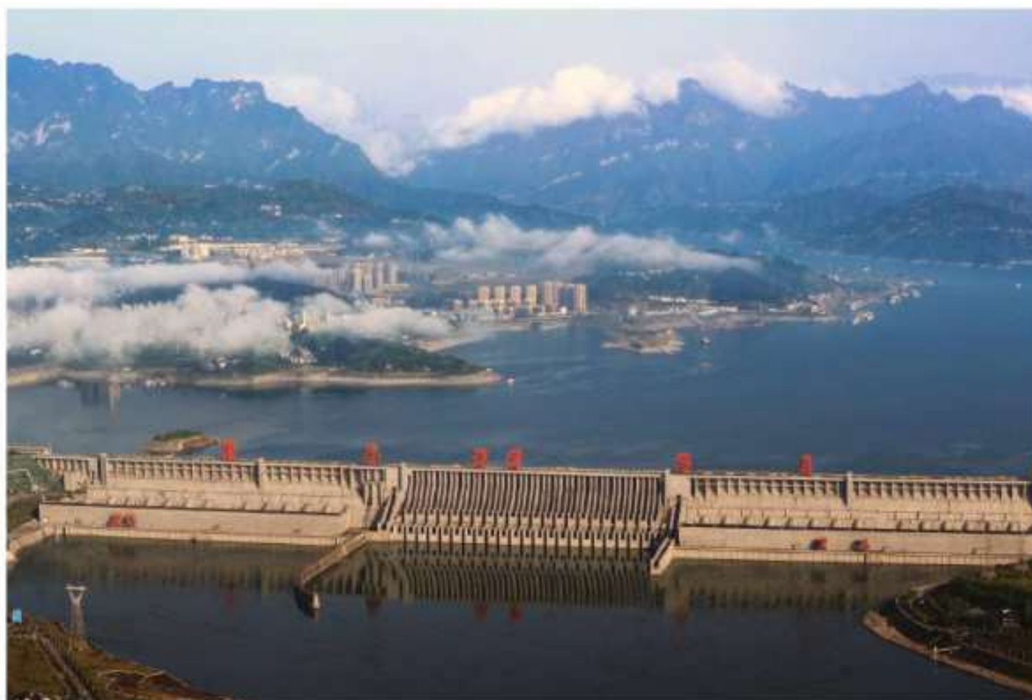
Ryc. IV.2.4. Zapora Trzech Przełomów ma ponad 2 km długości, a jej grubość u podstawy wynosi 115 m.
