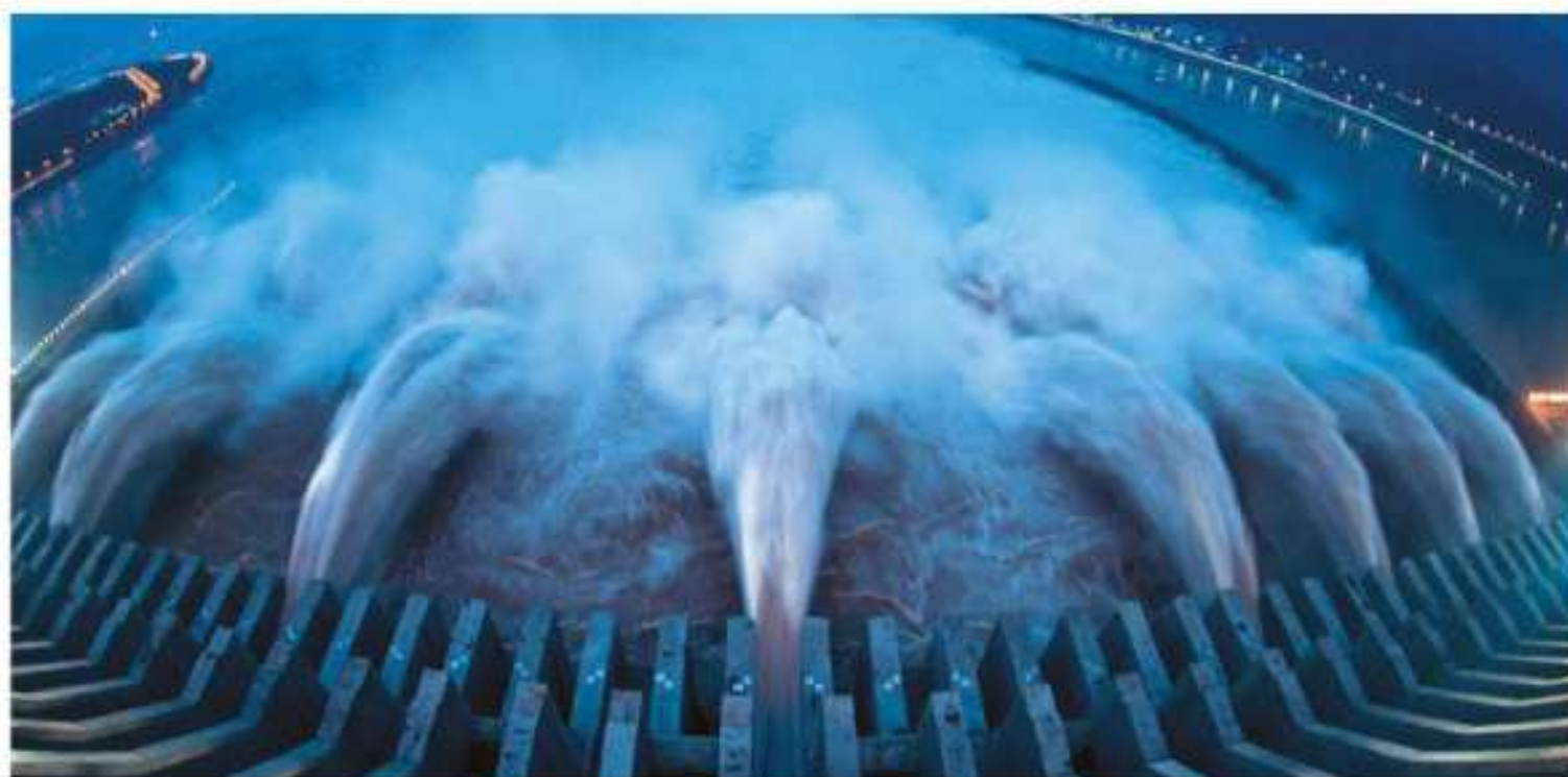
Ryc. IV.2.1. Napełnianie zbiornika Zapory Trzech Przełomów.
