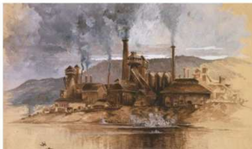
Ryc. III.3.2. Zakłady Stali Betlejem w Pensylwanii w USA i generowane przez nie zanieczyszczenie powietrza uwiecznione na akwareli z 1881 roku.
