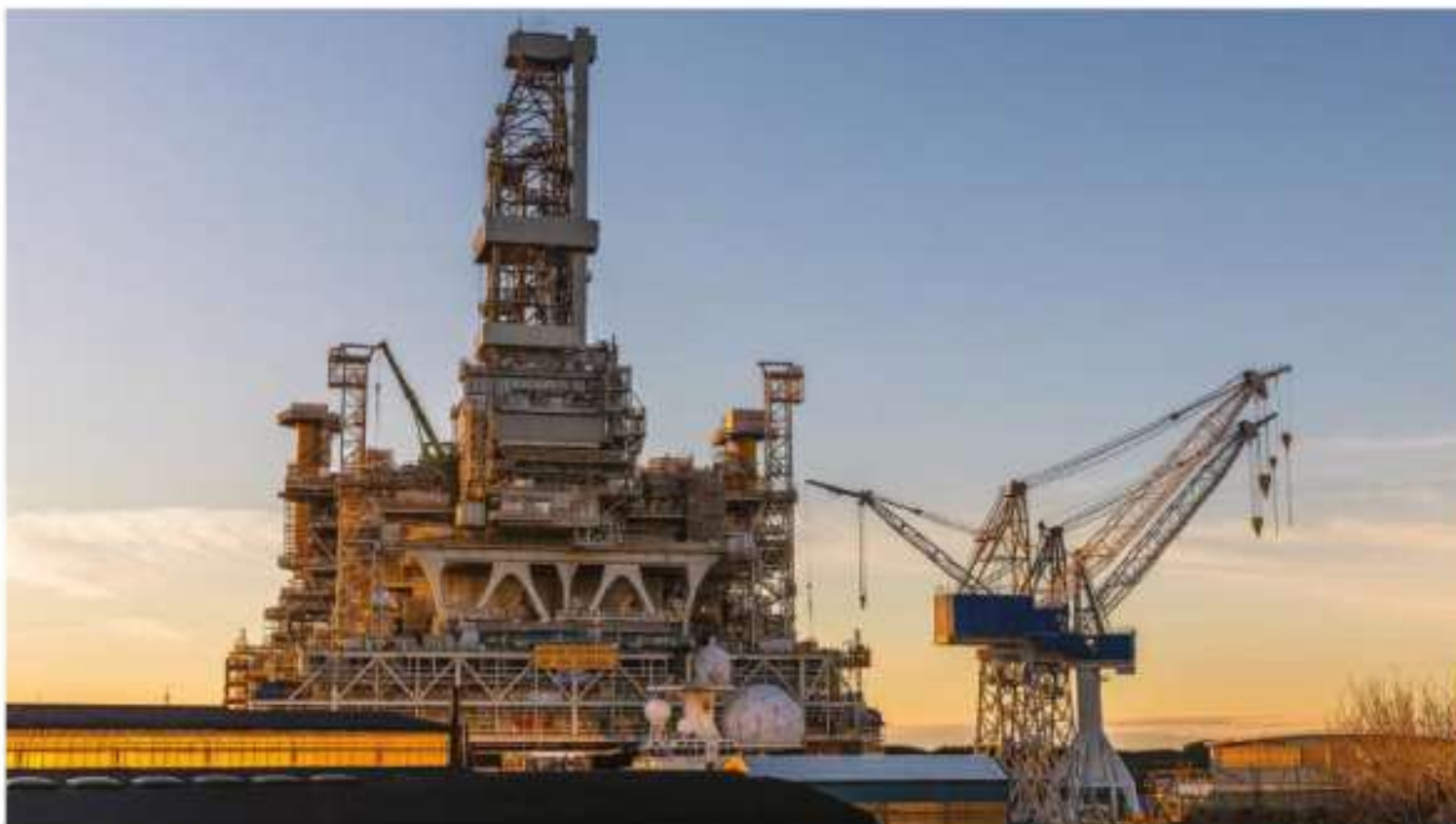
Ryc. IV.6.6. Norweska platforma wiertnicza Johan Sverdrup na Morzu Północnym wydobywająca ropę naftową z szelfu morza. Platforma jest zasilana energią elektryczną dostarczaną z lądu.
