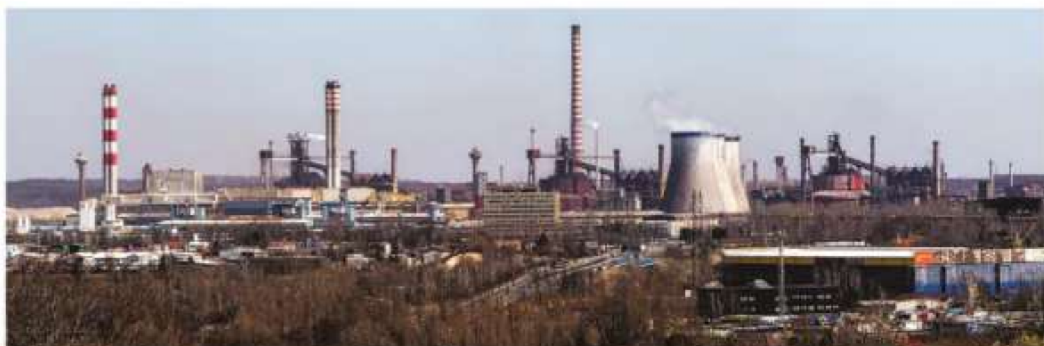
Ryc. I.8.2. Huta Katowice w Dąbrowie Górniczej powstała w 1976 r.
