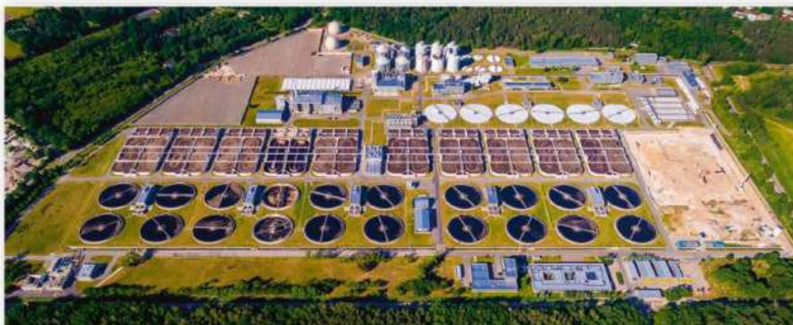
Ryc. I.7.9. Oczyszczalnia ścieków Czapka w Warszawie.
