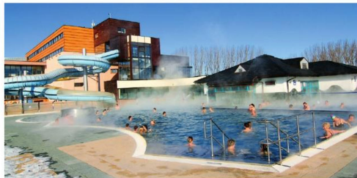
3.29 Kompleks basenowo-hotelowy Aquacity Poprad [czyt. akwasiti poprad], ogrzewany wodami termalnymi
