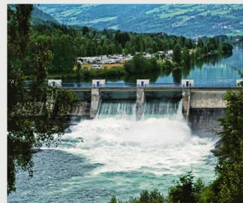
2.52 Hydroelektrownia Hunderfossen, niedaleko Lillehammer
