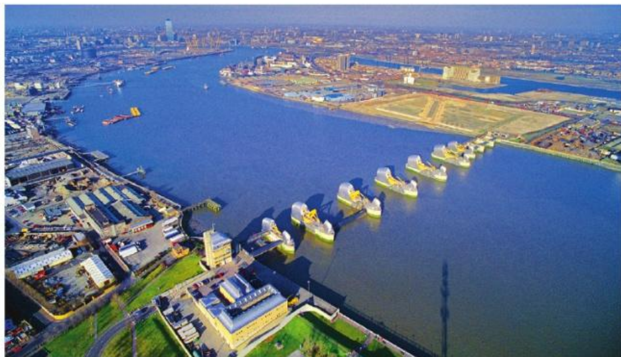
2.33 Nowoczesny system śluz potrafi szybko odciąć napływające do Tamizy wody morskie
