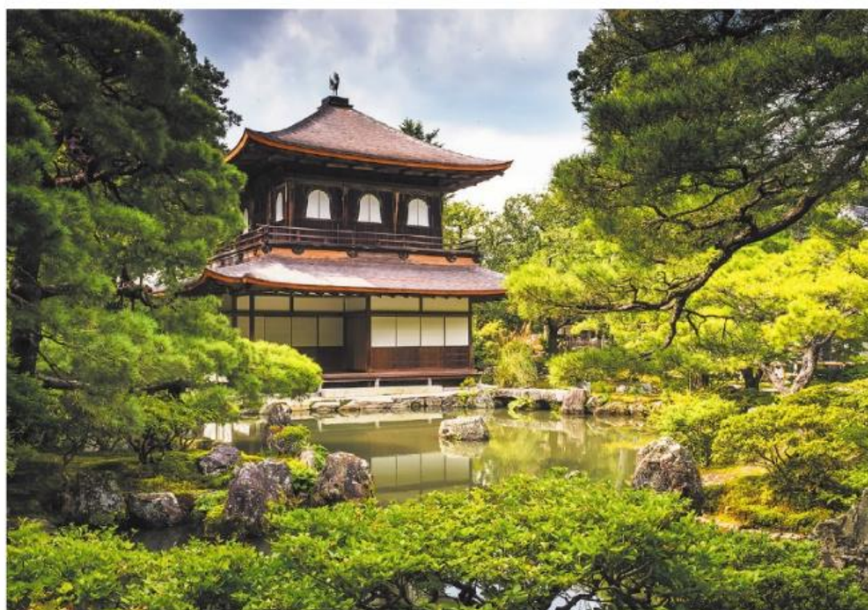
1.26 Świątynia Ginkaku-ji [czyt. ginka-kudzi] – przykład tradycyjnej drewnianej architektury odpornej na trzęsienia ziemi i ulewne deszcze
