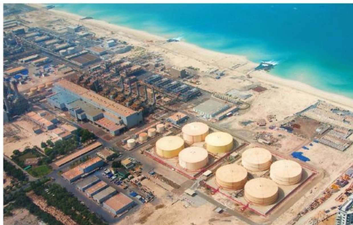
1.63 Budowa odsalarni wody morskiej to inwestycja, która wymaga dużych nakładów finansowych
