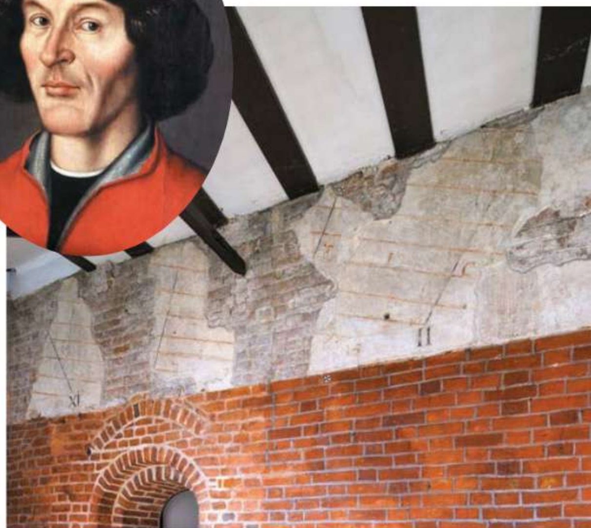
▲ Pozostałości po tablicy astronomicznej wykreślonej ręką Kopernika na ścianie zamku w Olsztynie. Tablica ta służyła uczonemu do obserwacji równonocy wiosennej i jesiennej.
