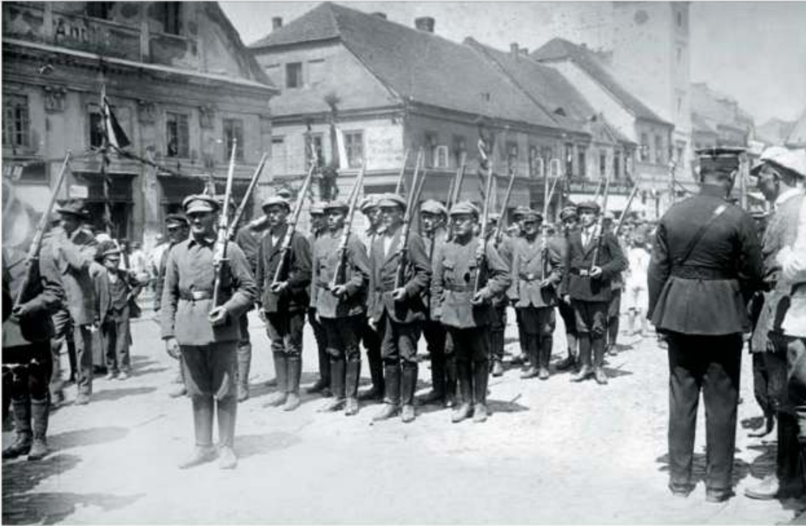
◀ Rybnik. Oddział powstańców – ochotników walczących w III powstaniu śląskim. Zwróć uwagę na brak umundurowania u powstańców oraz na ich słabe uzbrojenie i wyposażenie.
