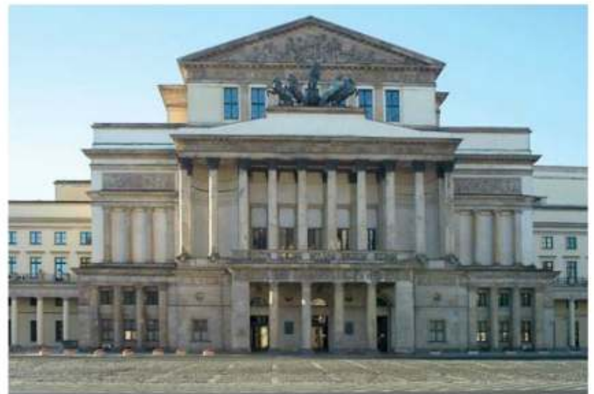
▲ Teatr Wielki , widok współczesny. Budowę teatru rozpoczęto w 1825 r. według projektu Antonia Corazziego, znakomitego warszawskiego architekta włoskiego pochodzenia. Gmach został wzniesiony w stylu klasycystycznym, dominującym w pierwszej połowie XIX w.
