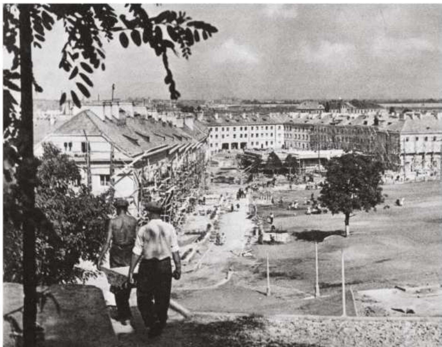
Budowa osiedla na Mariensztacie, na warszawskim Śródmieściu, zbudowanego w rekordowym tempie niecałych 2 lat (1948–1949)
