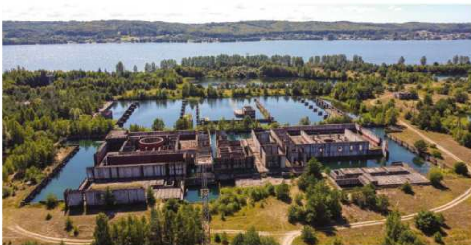
Fundamenty nigdy nieukończonej elektrowni atomowej w Żarnowcu
