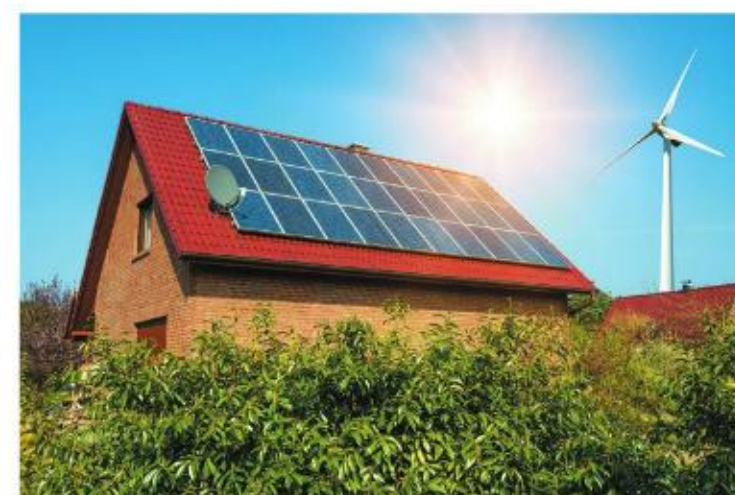
4.5 Panele fotowoltaiczne i wiatrak
