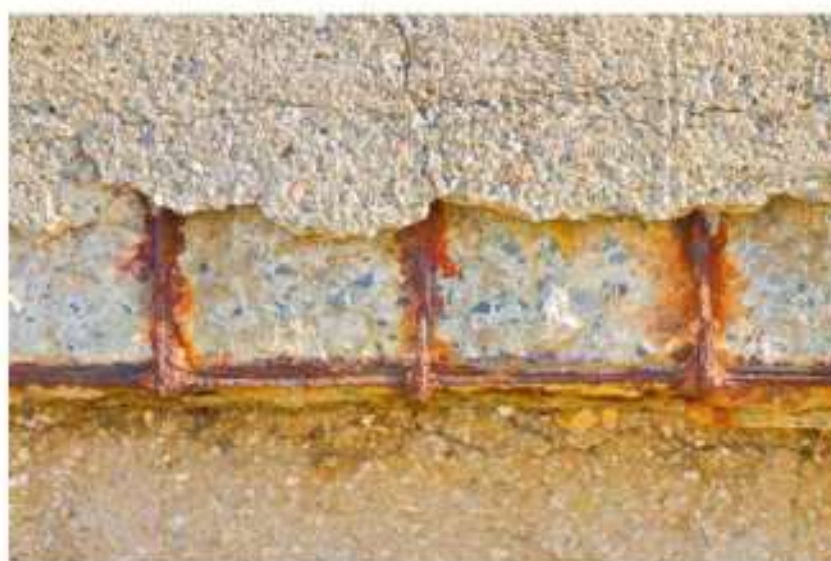
Rys. 12.1. Skorodowany beton.
