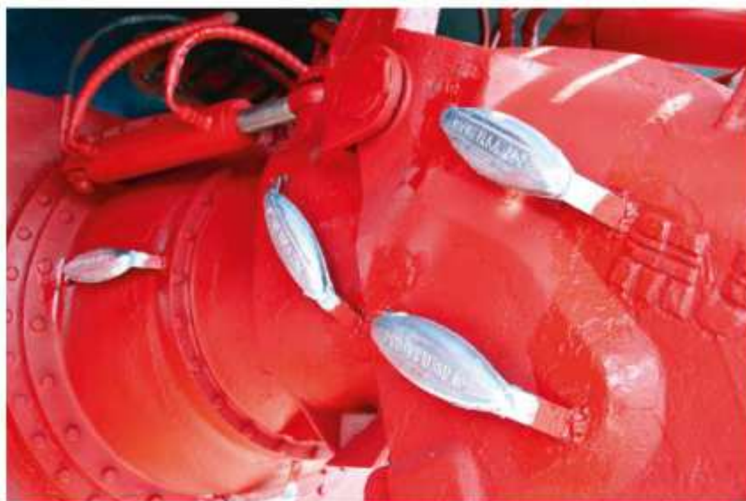
Rys. 12.11. W przypadku części statków narażonych na działanie wody morskiej ochronę protektorową stanowią umieszczane na nich płyty cynkowe.
