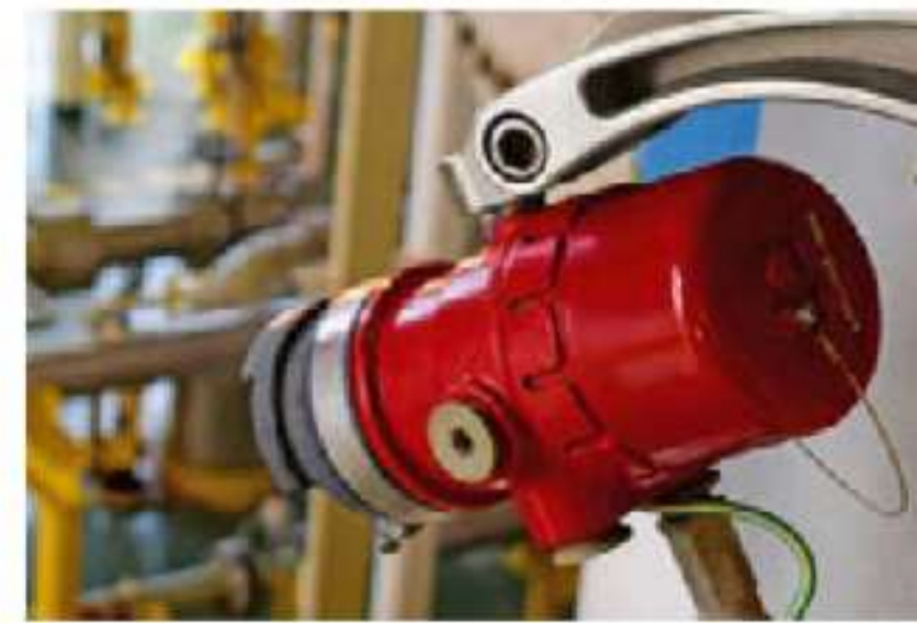
Rys. 19.7. Dzięki efektowi fotoelektrycznemu działają niektóre wykrywacze płomienia. Są to czujniki promieniowania nadfioletowego, nieczułe na światło widzialne
