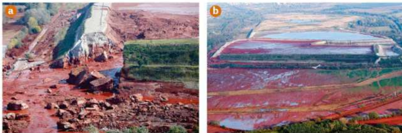
Rys. 4.3. Katastrofa w Kolontarze w 2010 r.: a) wyrwa w wale zbiornika czerwonego szlamu; b) obszar skażony przez wyciek.
