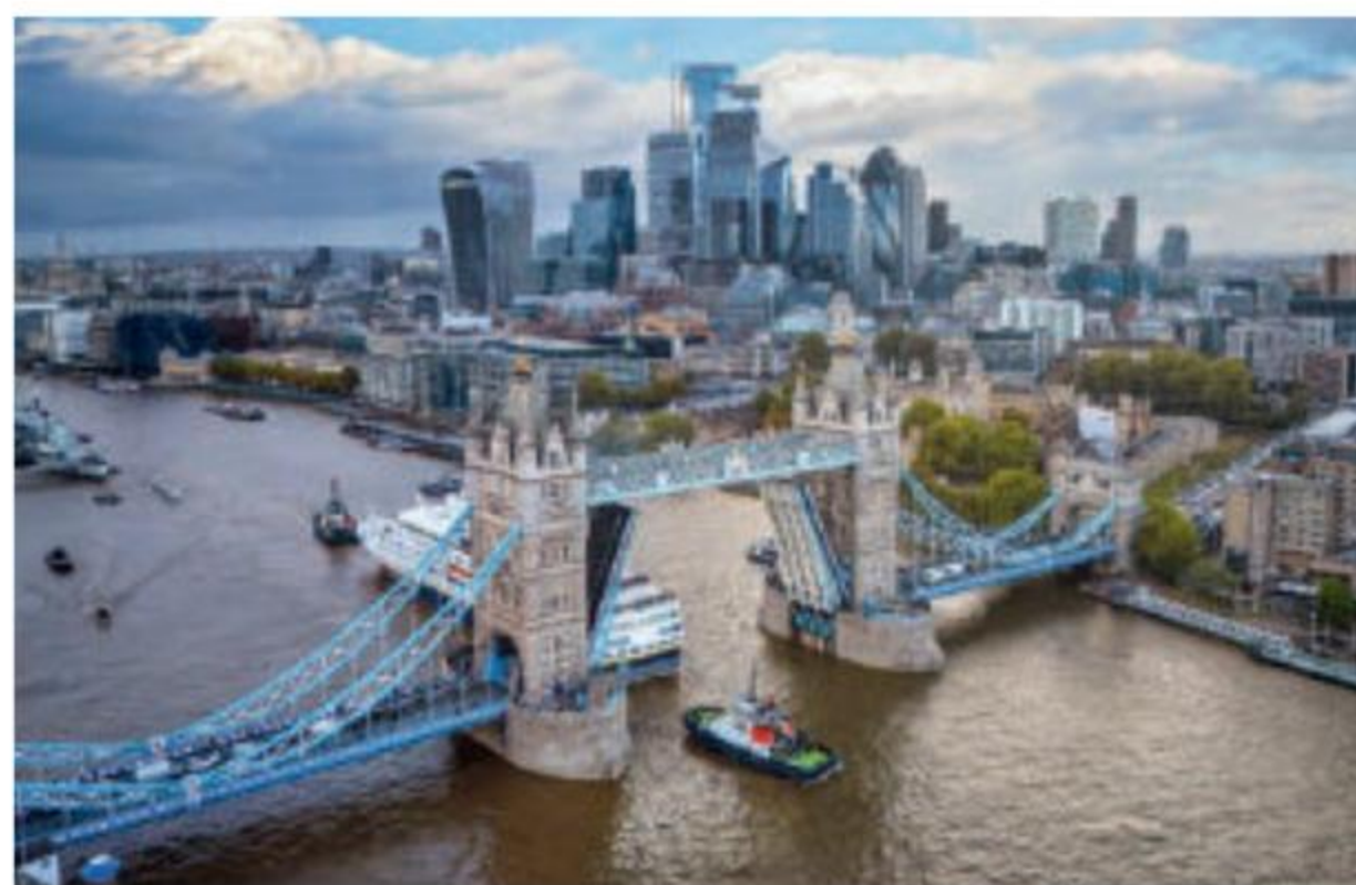
▲ Tower Bridge – jeden z symboli Londynu – to most zwodzony. Jego środkowa część jest podnoszona, gdy muszą pod nim przepłynąć statki.
