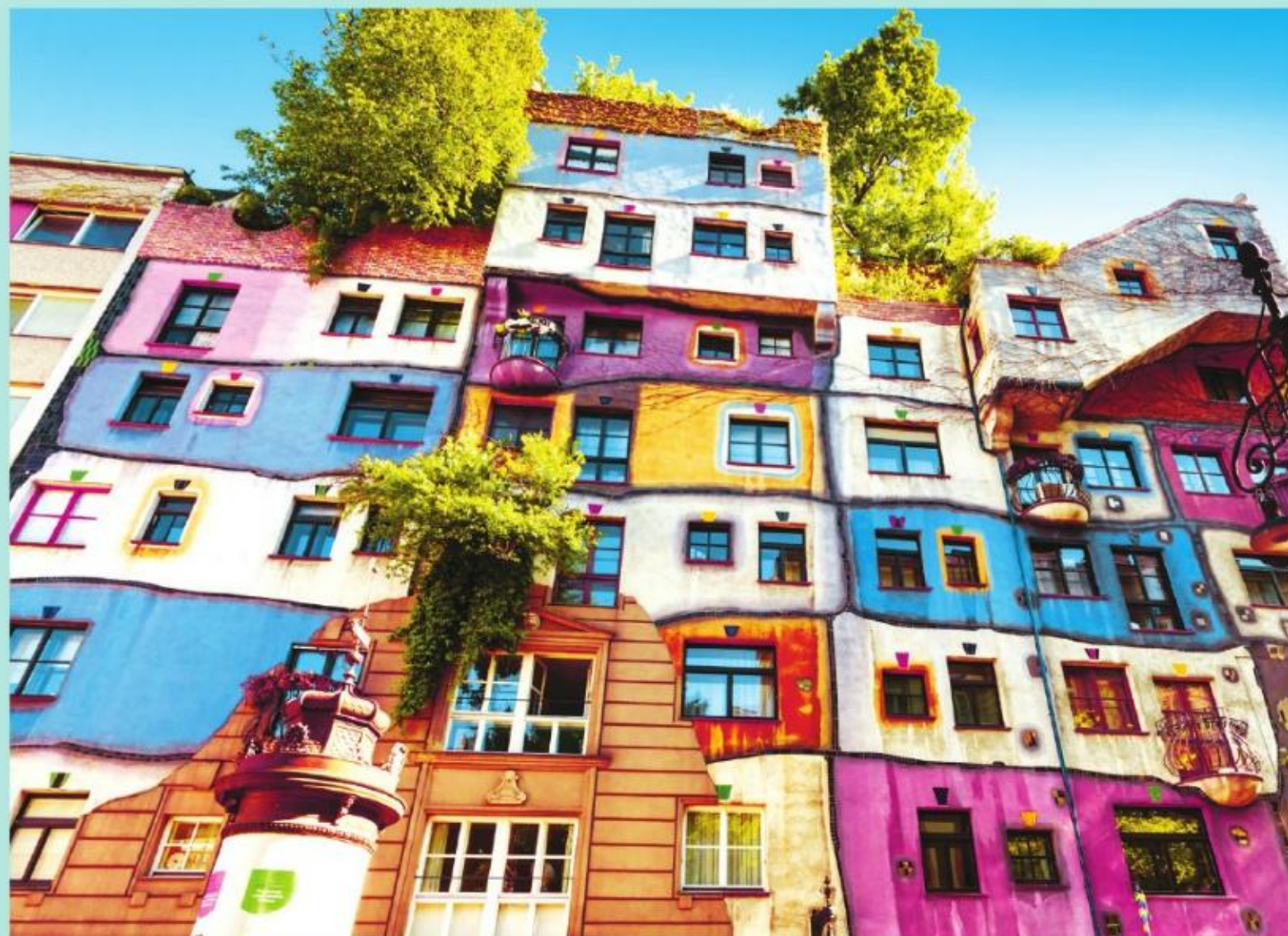
Dom Hundertwassera, kompleks mieszkalny w Wiedniu
