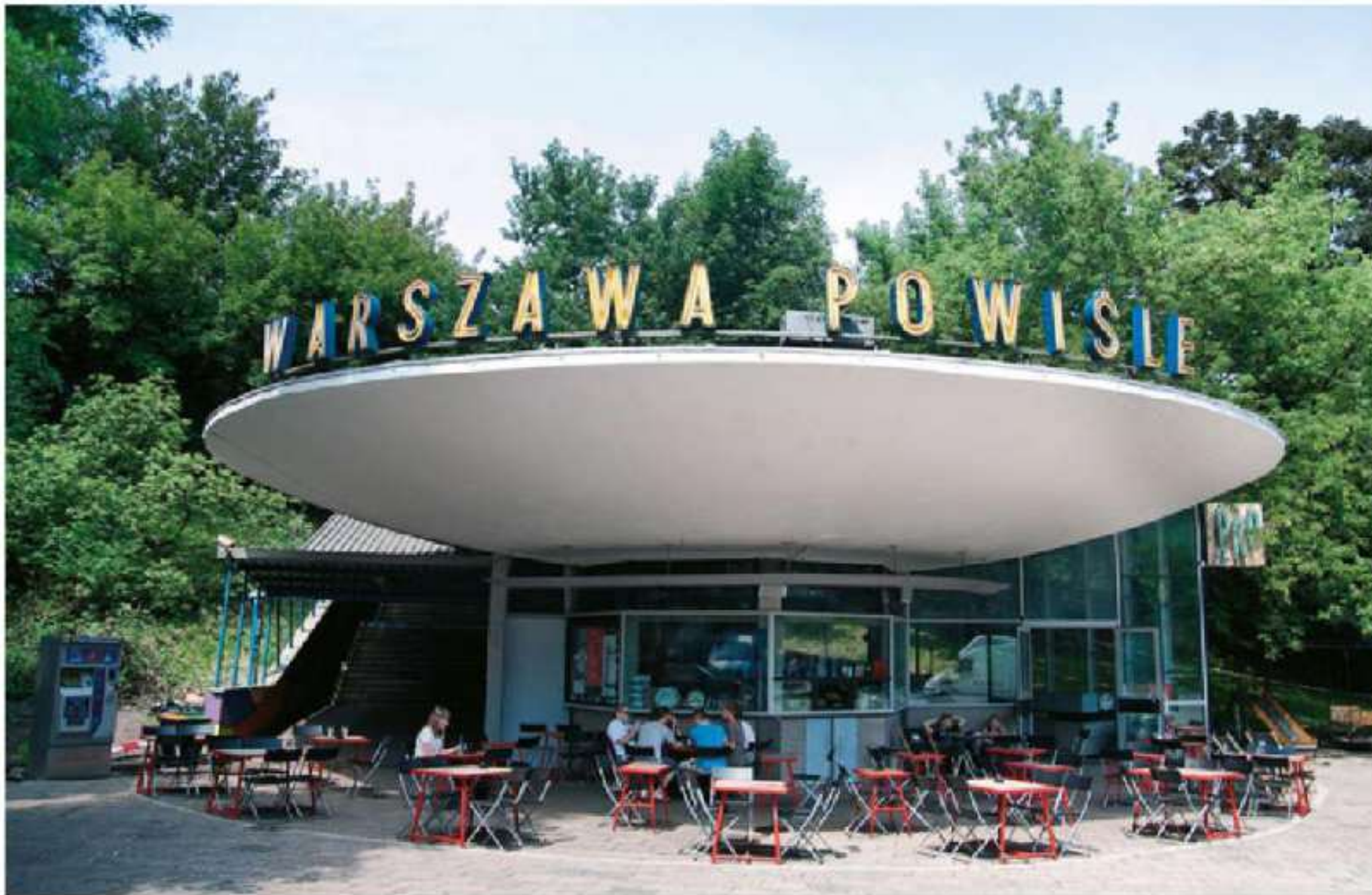
ARSENIUSZ ROMANOWICZ, PIOTR SZYMANIAK, kasy biletowe stacji kolejowej Warszawa Powiśle, 1963 r.
