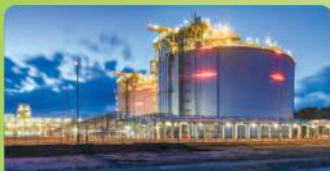
TERMINAL SKROPLONEGO GAZU ZIEMNEGO ŚWINOUJŚCIE
