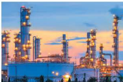
▲ Rafineria ropy naftowej
