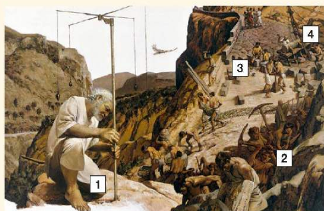
Budowa rzymskiej drogi rozpoczynała się od wyznaczania jej przebiegu [1]. Następnie wyrównywano teren [2] i układano nawierzchnię [3]. Na końcu stawiano przy niej kamienie milowe [4].
